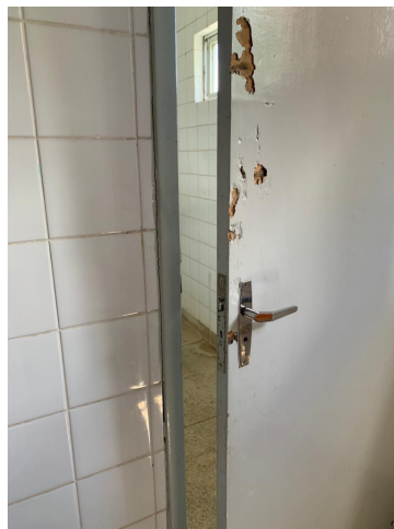
39.97. Sala Parto Banheiro
