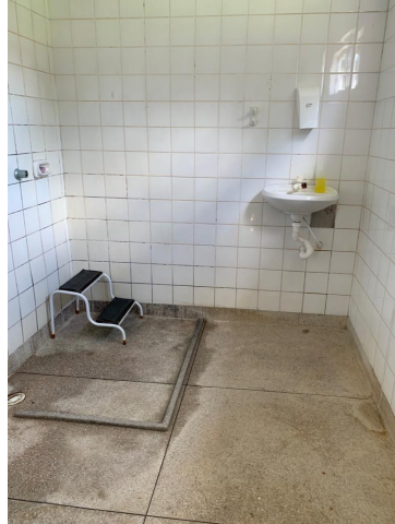
39.98. Sala Parto Banheiro
