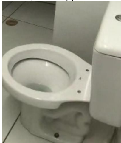
24.27. Banheiro unissex com vaso sem tampa
