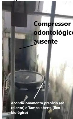
24.23. Área para Casa do Compressor odontológico, de onde o mesmo havia sido removido para reparo e bombona de lixo biológico aberta e mal acondicionada (ao relento) com lâmina de água de chuva na tampa
