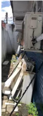
24.6. Lateral com materiais depositados e compressores de ar condicionado
