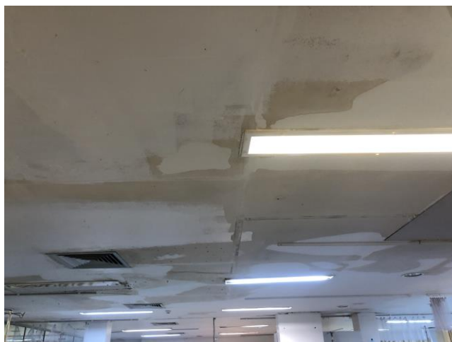
26.1. Forro do teto restaurado
