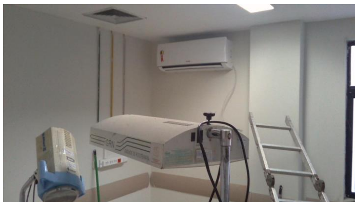
23.6. SALA DE ISOLAMENTO EM PREPARAÇÃO PARA LEITOS COMUNS
