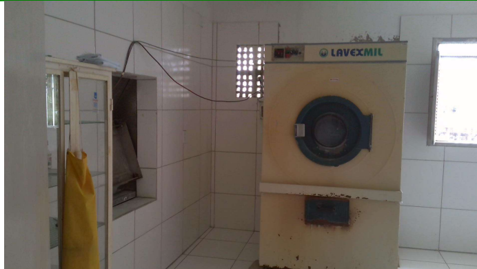
32.19. Lavanderia - parte limpa (foto 1)
