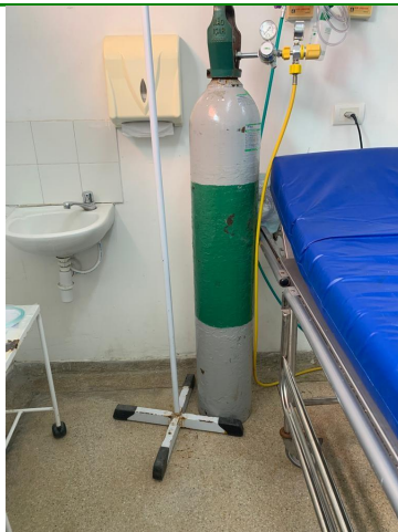
26.63. S Verm Ped Cilindro nao fixado
