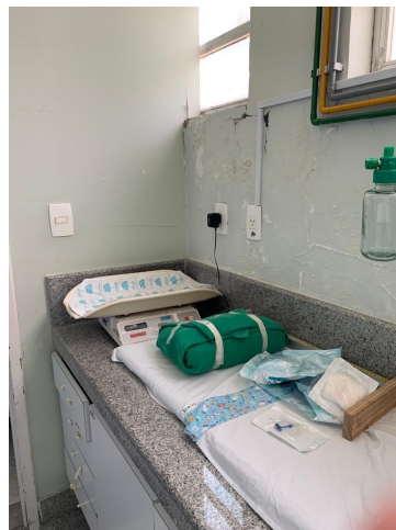
29.49. Matern Infiltr, Rachadura e Mofo
