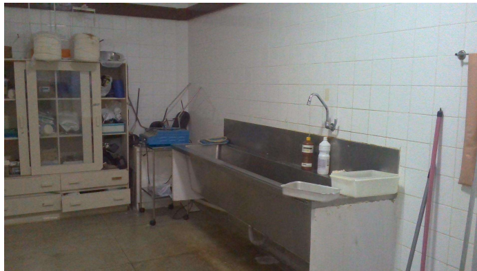
55.35. Lavabo do bloco cirúrgico
