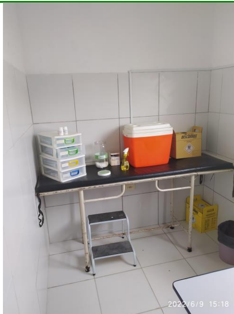
29.15. Sala de vacinação com lixeira sem tampa
