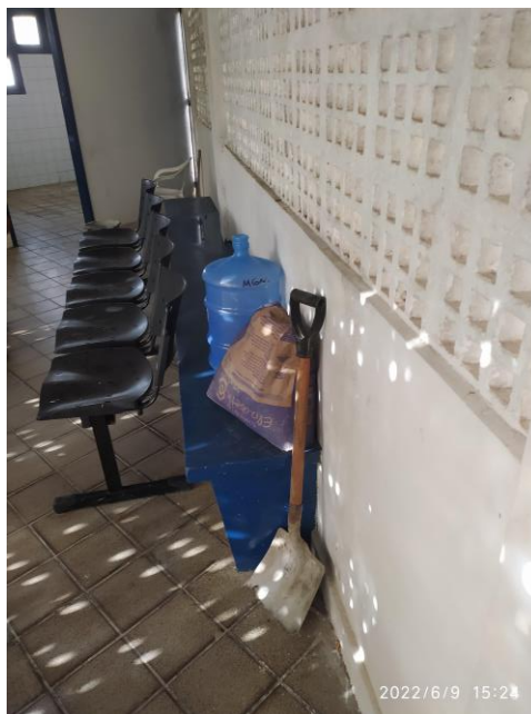
29.22. Área interna com longarinas e garrafões de água no chão não está em uso
