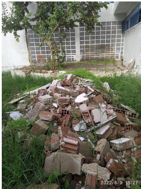
29.26. Área externa sem capinação e com metralha
