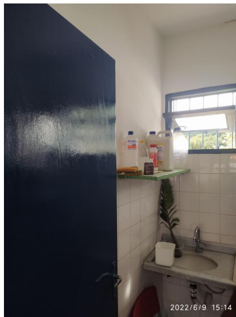
29.4. Quarto onde fica banheiro de funcionários único e o DML (depósito de material de limpeza)
