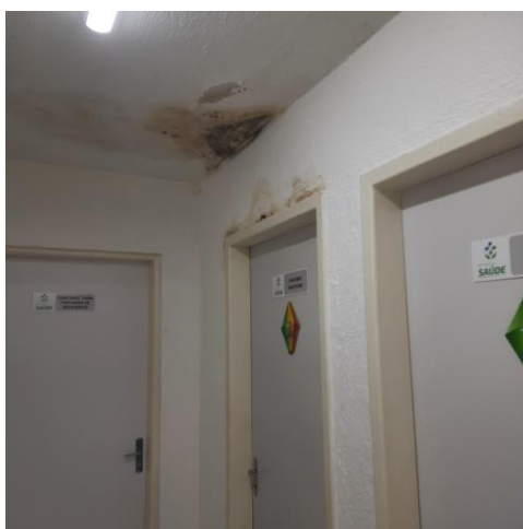
29.9. Infiltração próximo aos banheiros para usuários
