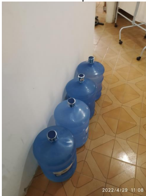
31.29. Garrafões de água diretamente no chão contrariam normas de higiene e limpeza
