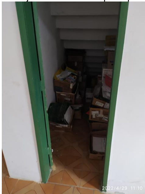
31.31. Quartinho abaixo de escada (da laje da construção) serve como depósito de prontuários e materiais sem uso
