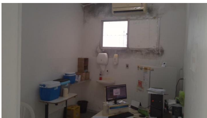
30.12. Sala de imunização / vacinação
