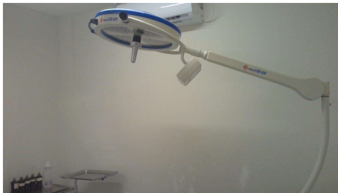
18.17. Sala de procedimentos (foto 2)
