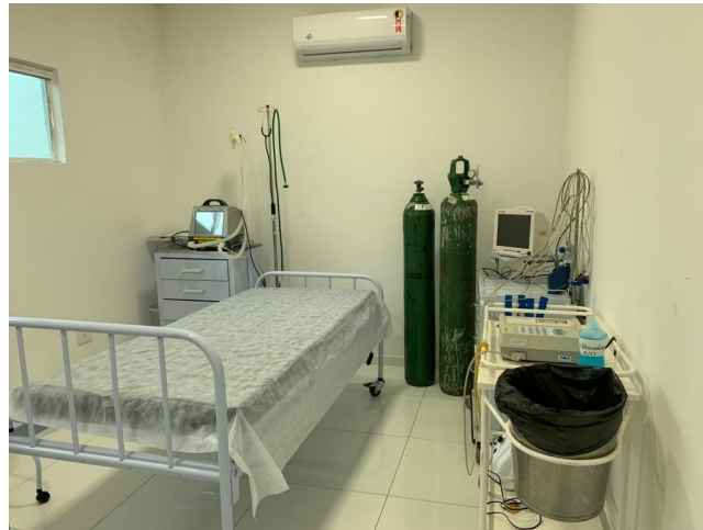
31.31. Sala Verm com 1 leito split e cilindro de oxigenio nao fixado
