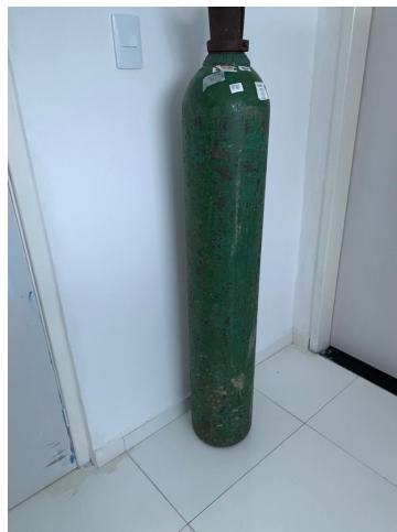
31.64. Enf Masc com cilindro de oxigenio nao fixado
