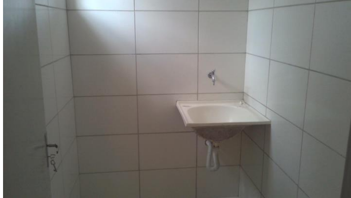
27.13. NOVA UBS - VISÃO INTERNA
