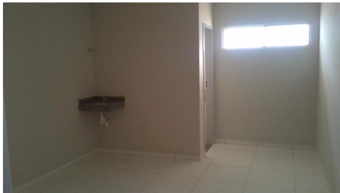
27.14. NOVA UBS - VISÃO INTERNA
