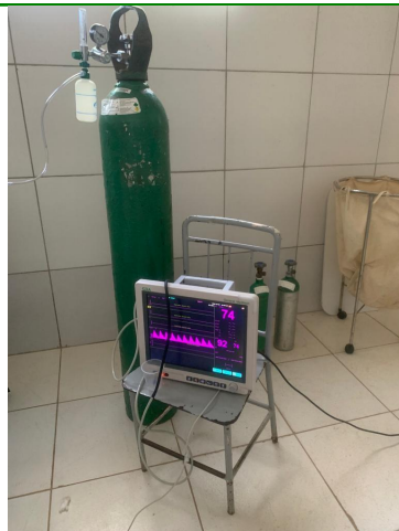
30.43. Sala Vermelha Cilindro Oxigenio Nao Fixado
