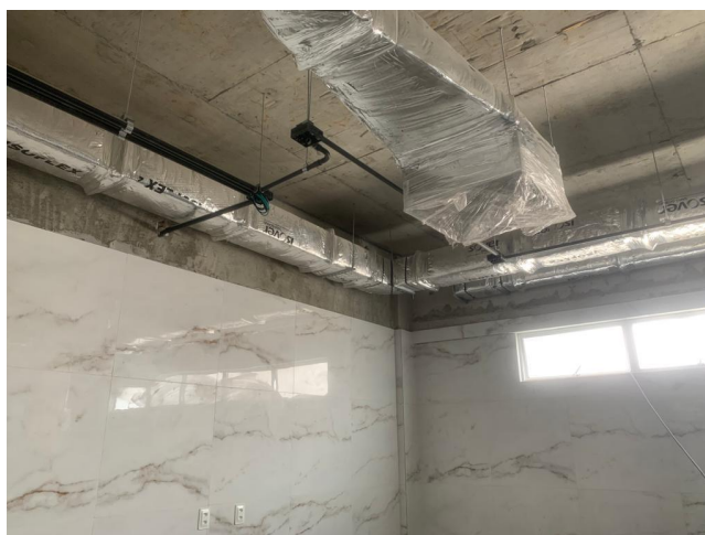
20.37. Construção Novo Centro Cirurgico
