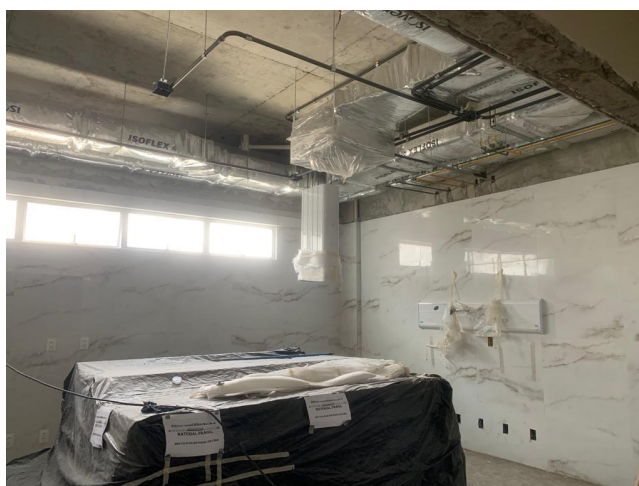
20.36. Construção Novo Centro Cirurgico
