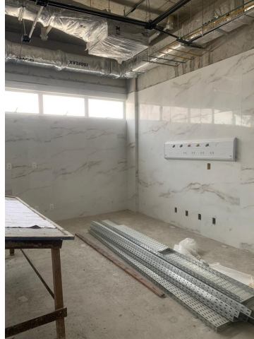
20.38. Construção Novo Centro Cirurgico
