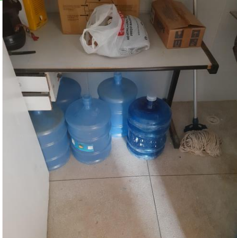
30.16. DML (depósito de material de limpeza) armazena água mineral no chão
