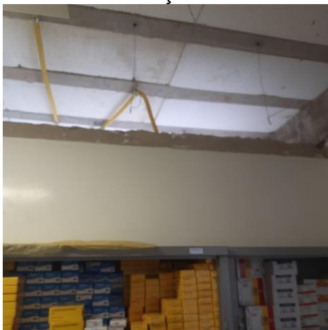
30.9. Farmácia com teto sem forro e sem climatização
