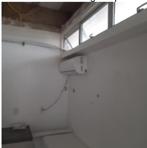
30.12. Sala de procedimento: Teto sem forro
