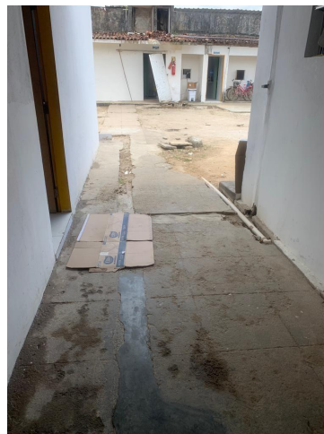
31.65. Corredor Interno Junto Bloco Cirurgico
