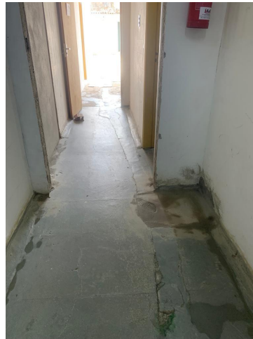
31.64. Corredor Interno Junto Bloco Cirurgico
