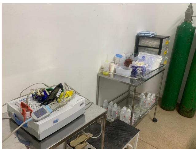
40.34. Sala Verm 2 com cilindro nao fixado
