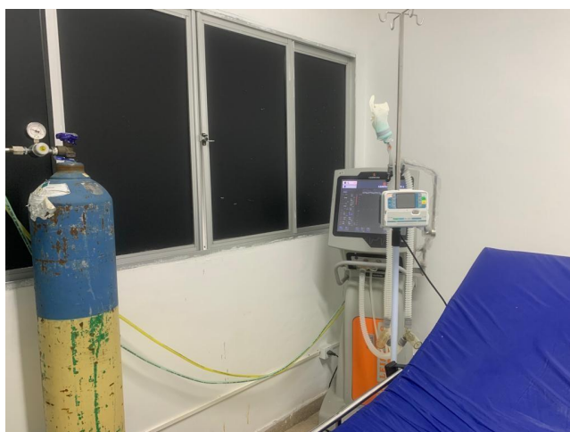
40.34. Sala Verm 2 com cilindro nao fixado
