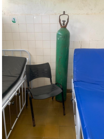
33.53. Enf Fem com cilindro não fixado
