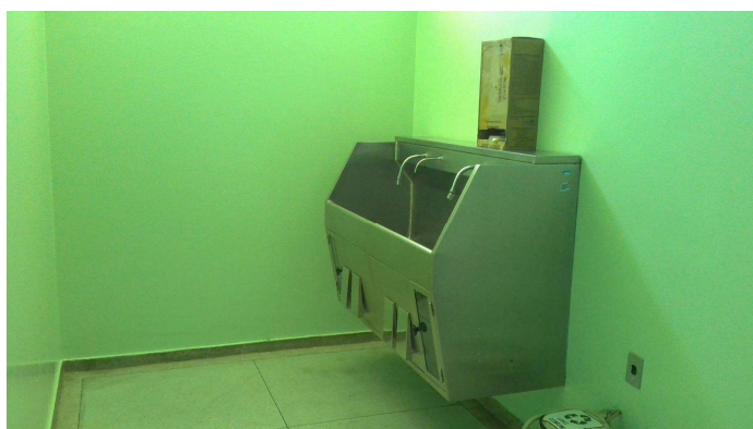
40.27. Lavabo com acionamento por pedal
