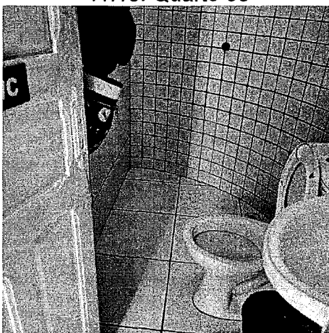
41.16. Banheiro para funcionários
