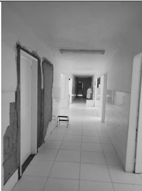
32.11. Antiga estrutura para atendimento Covid, sem fluxos nem rotinas
