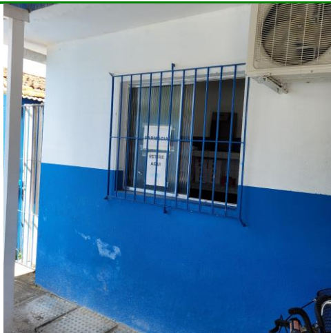
32.3. Janela para dispensação da Farmácia
