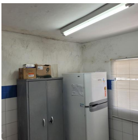
32.11. Sala de vacina com Infiltrações e Mofo
