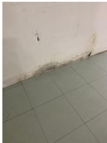
33.19. Corredor Int Infiltração e Mofo
