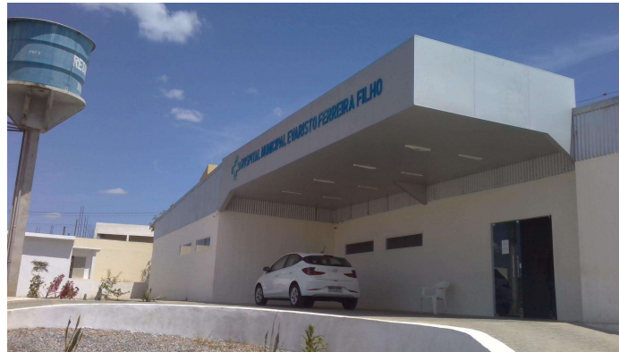
30.1. Hospital Municipal Evaristo Ferreira Filho
