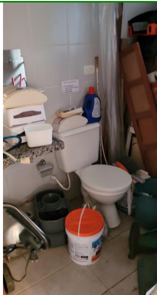
34.6. Banheiro do quarto em reforma com materiais depositados
