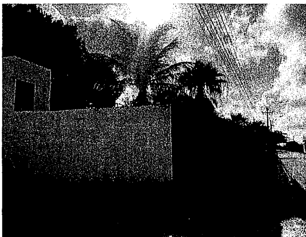
34.2. Fachada e Muro
