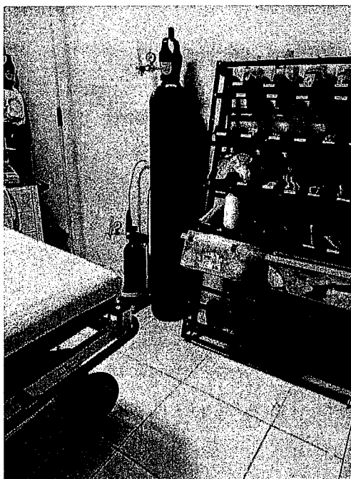
34.31. Sala vermelha 03: cilindros de Oxigênio sem fixação
