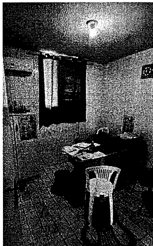
27.3. Sala administrativa, com infiltrações
