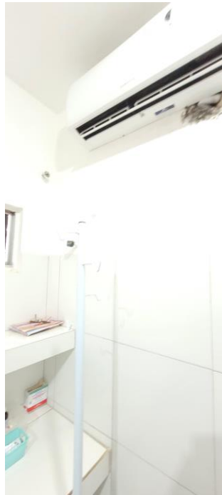
28.8. Ar condicionado com infiltração/ mofo na sala de medicação
