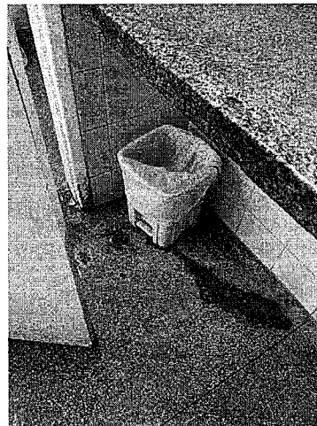
32.17. Banheiro Recepção com lixo sem tampa
