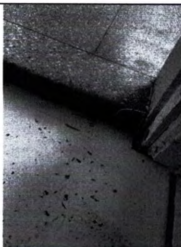
32.13. Recepção Banheiro Degrau
