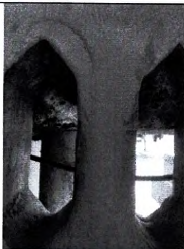
32.68. Corredor Interno Mofo
