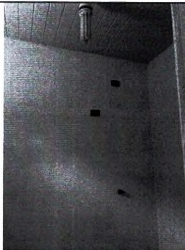
30.33. Consultorio Enfermagem Banheiro
