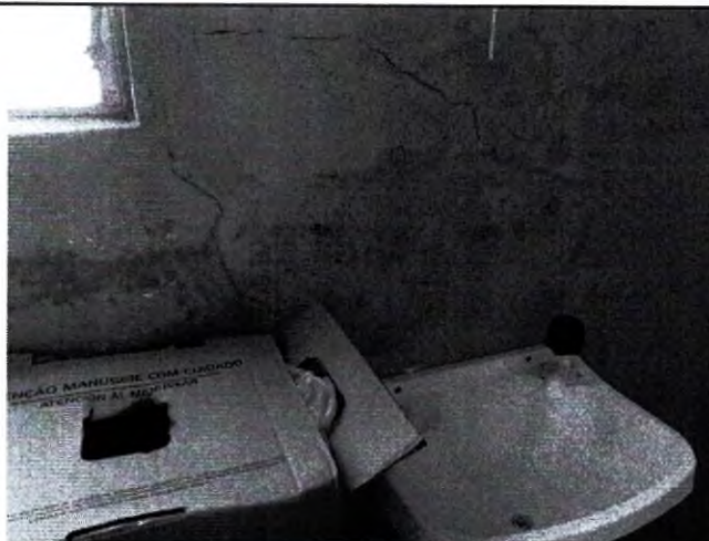
30.43. Sala Proced Mofo e Pia sem sabao liquido
