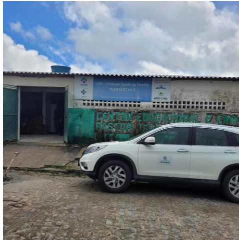
30.1. Unidade Original em Reforma
