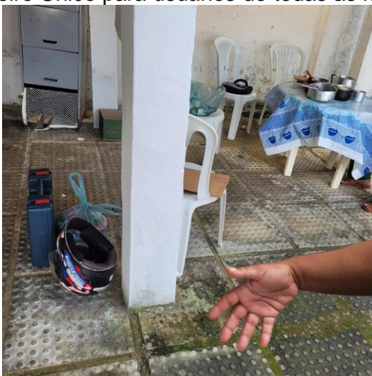
30.19. Copa/ Cozinha Improvisada no Subsolo/ Porão da casa
