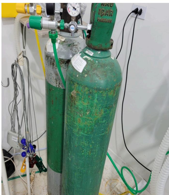
Cilindros de oxigênio na sala vermelha não estão fixados em carrinho ou correntes, com risco de acidentes
