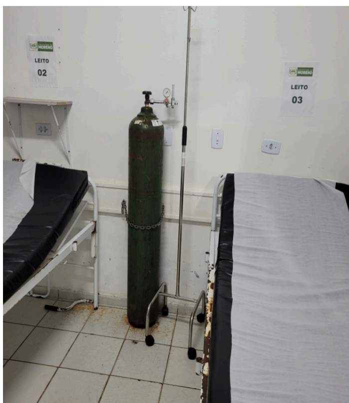
Há muitos torpedos de oxigênio na unidade sem fixação em carrinho ou corrente
