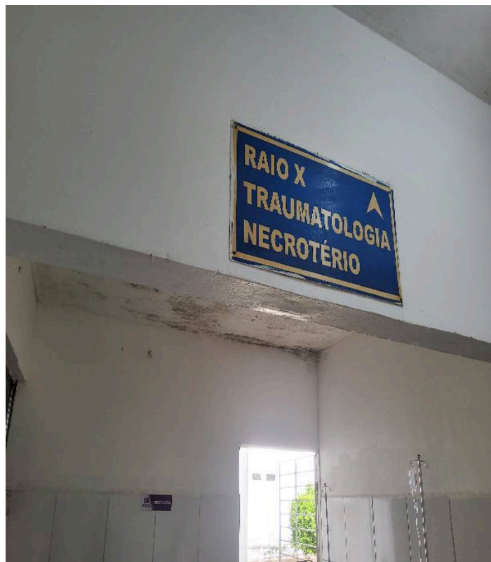
Sinalização de acessos
