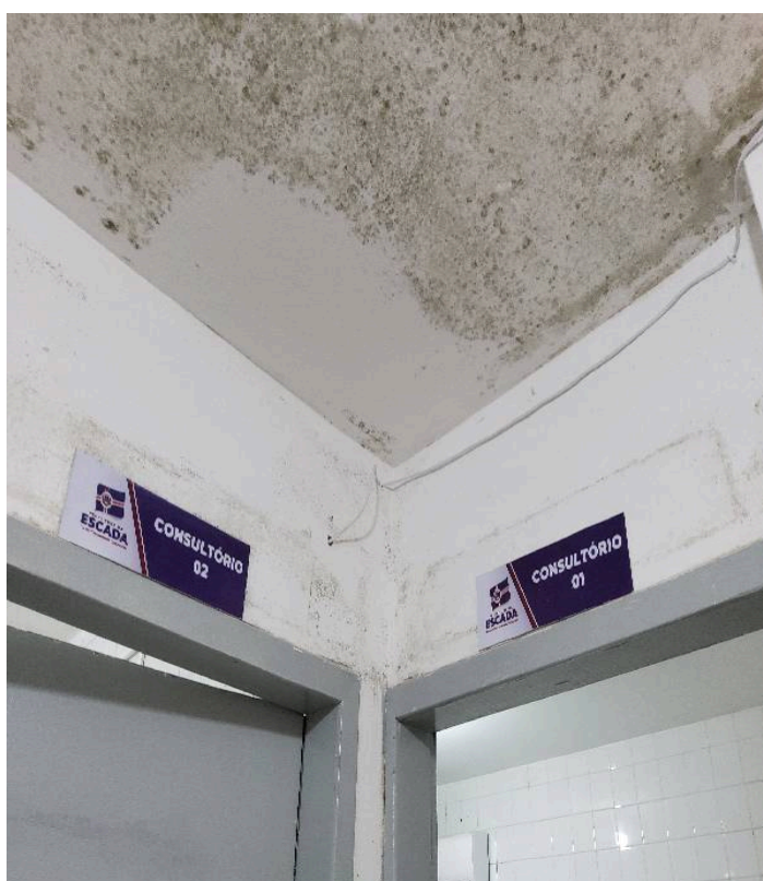
Sinalização de acessos
