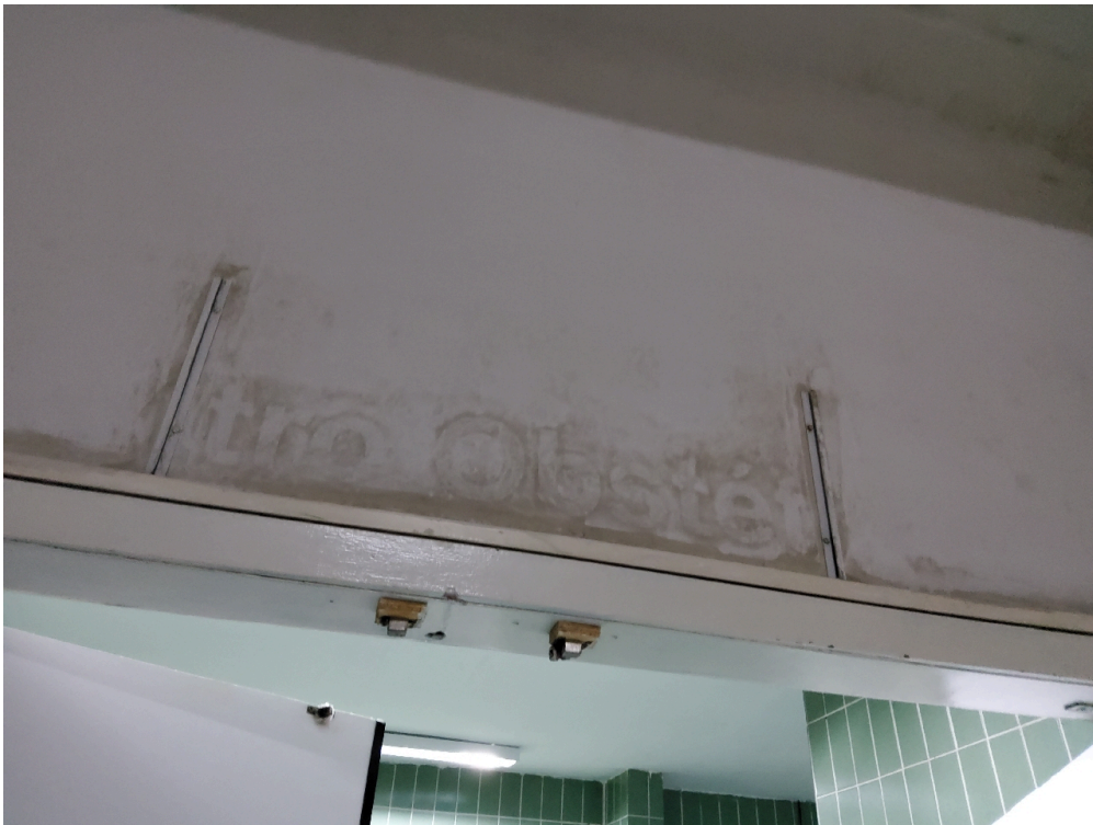
Centro cirúrgico obstétrico
