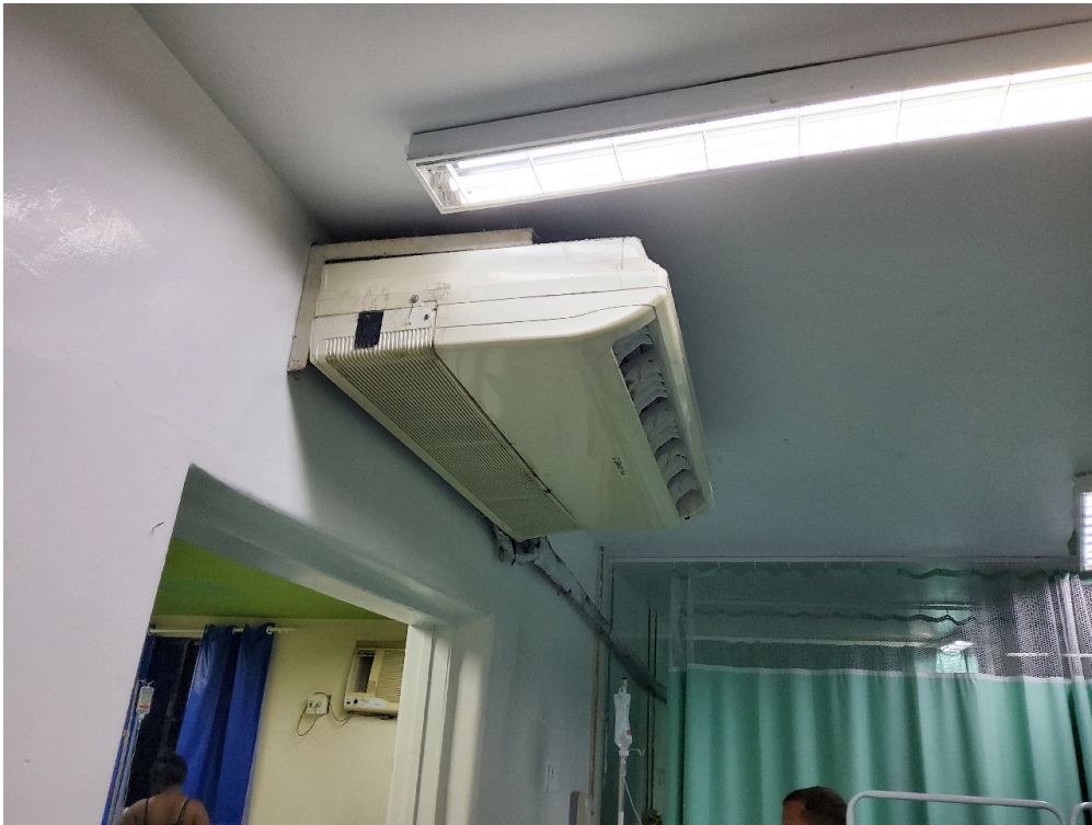
Salas em sistema de PPP (pré-parto, parto e puerpério)
