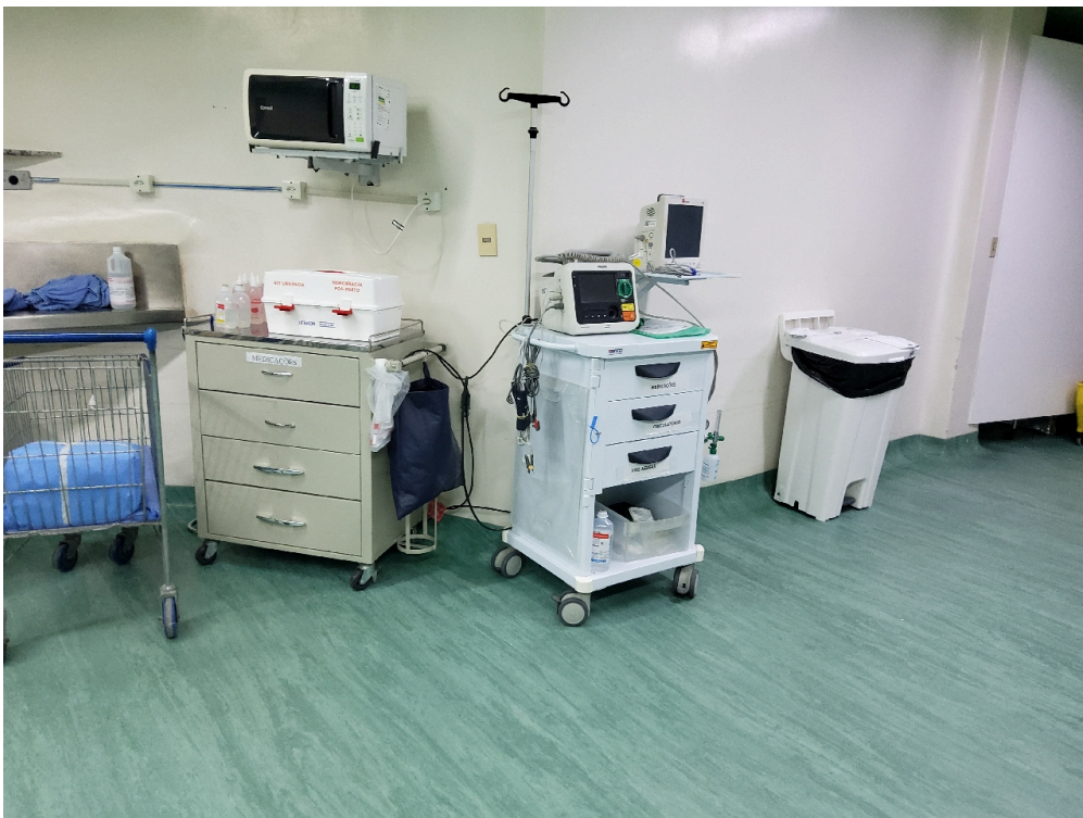
Centro cirúrgico obstétrico
