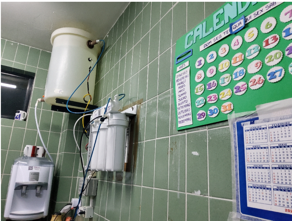
Centro cirúrgico obstétrico
