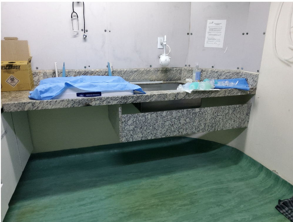
Centro cirúrgico obstétrico
