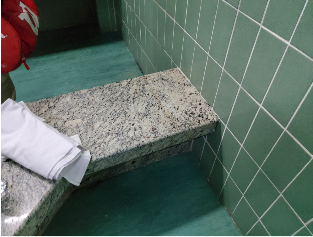
Centro cirúrgico obstétrico
