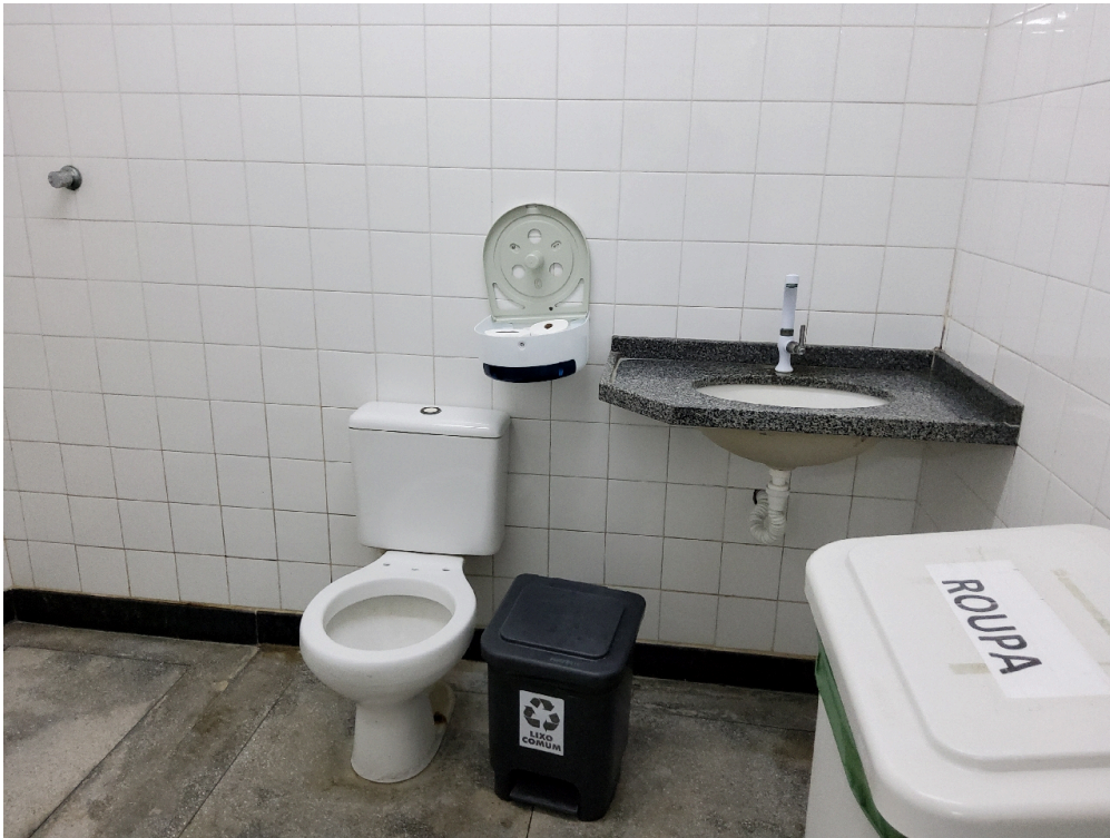
Banheiro da triagem obstétrica
