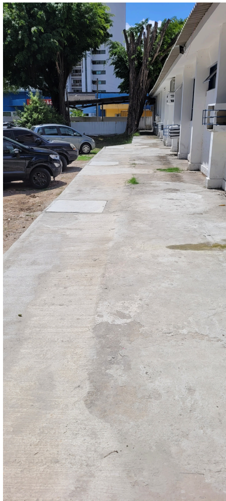
caixas de esgoto e saneamento da unidade recém construídos
