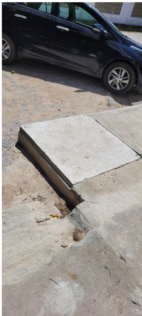
tampa de fossa recém construída
