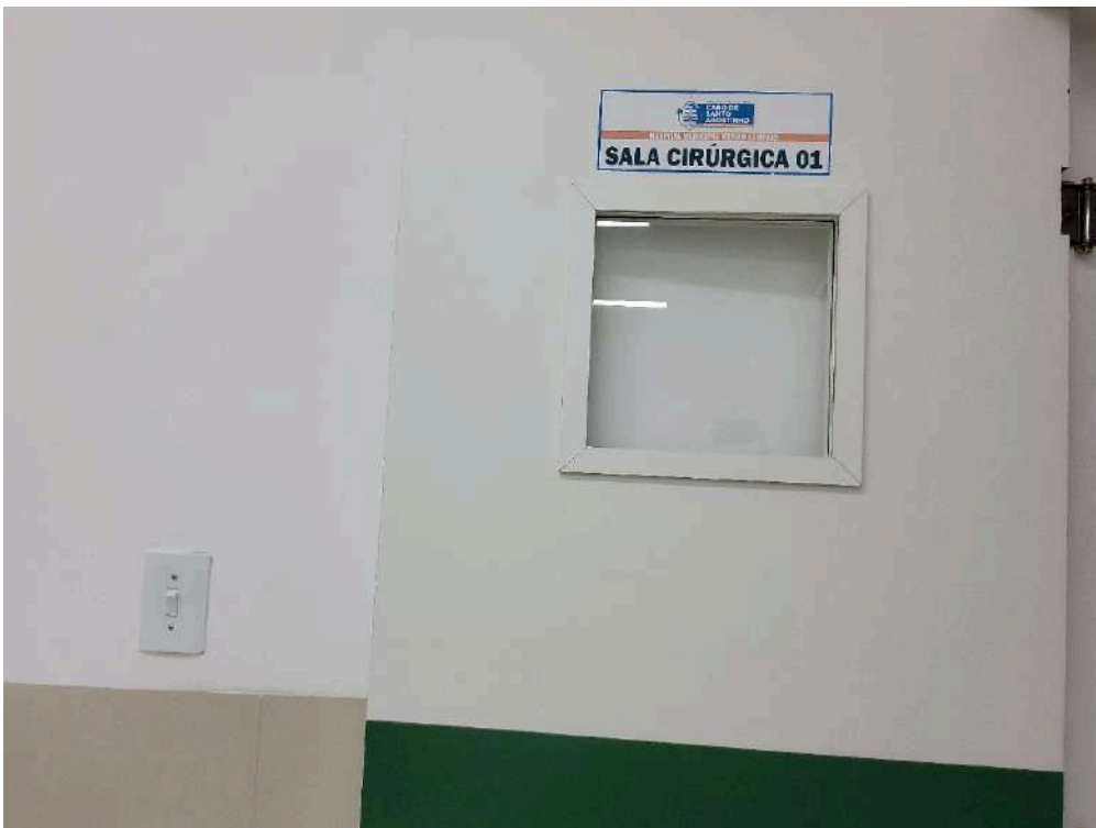
Sinalização de acessos
