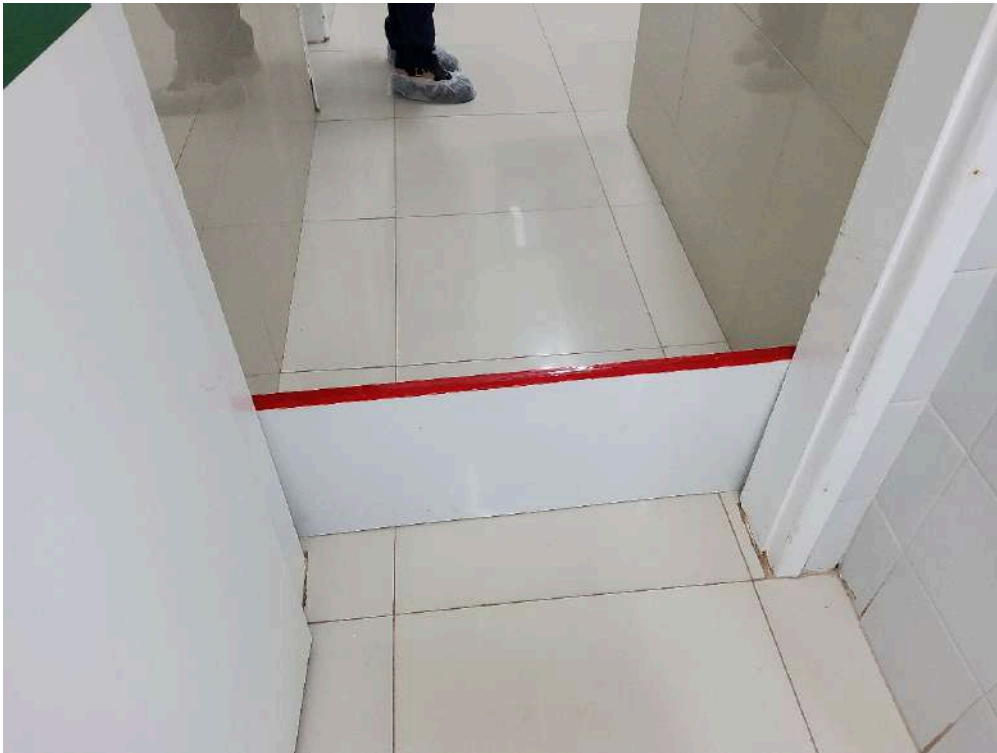
Sinalização de acessos
