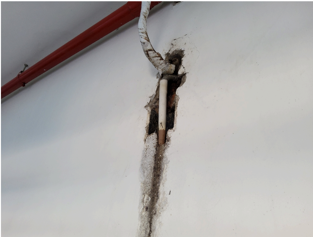
Instalações prediais livres de trincas, rachaduras, mofos e/ou infiltrações
