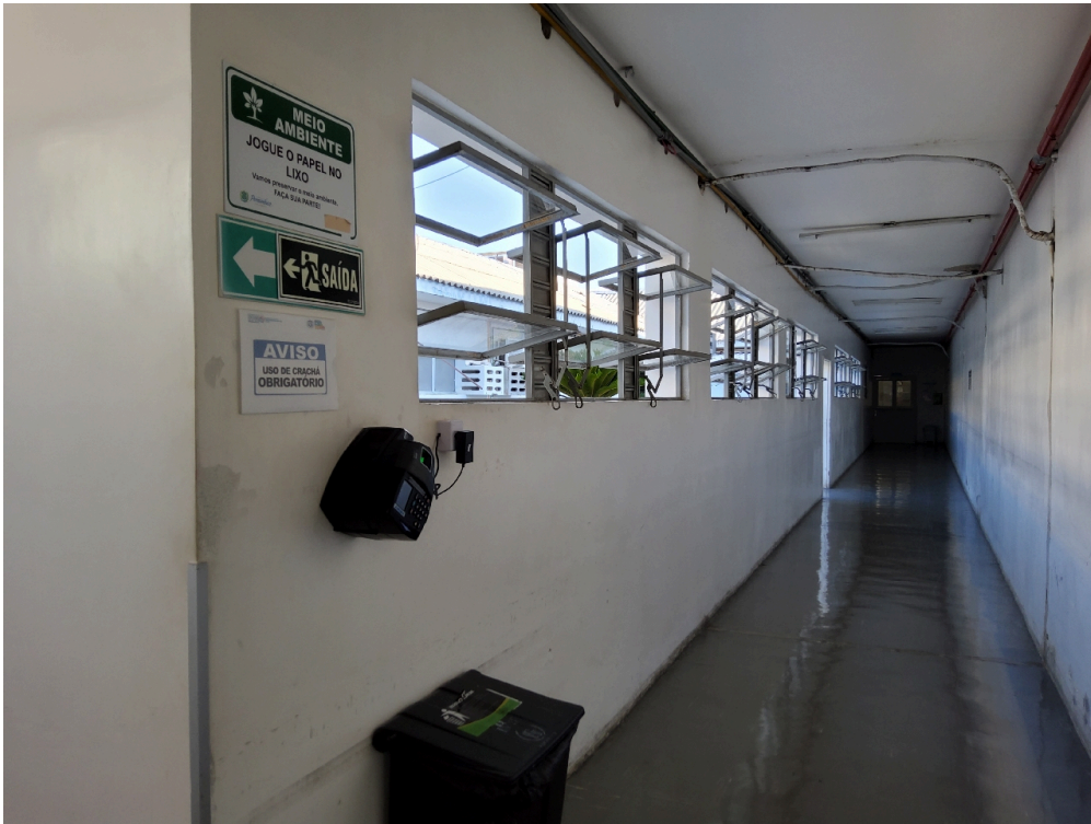
Sinalização de acessos
