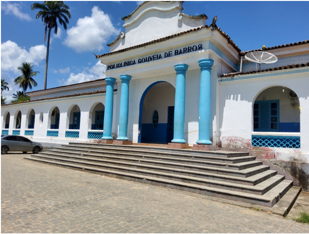
Local onde está funcionando a UM João Mayrink
