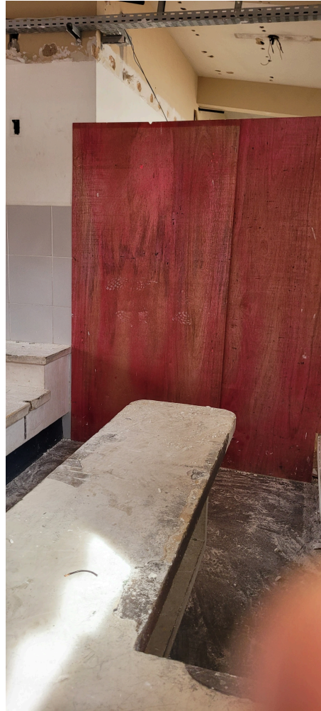
detalhes da obra em outro ambiente da unidade de saúde
