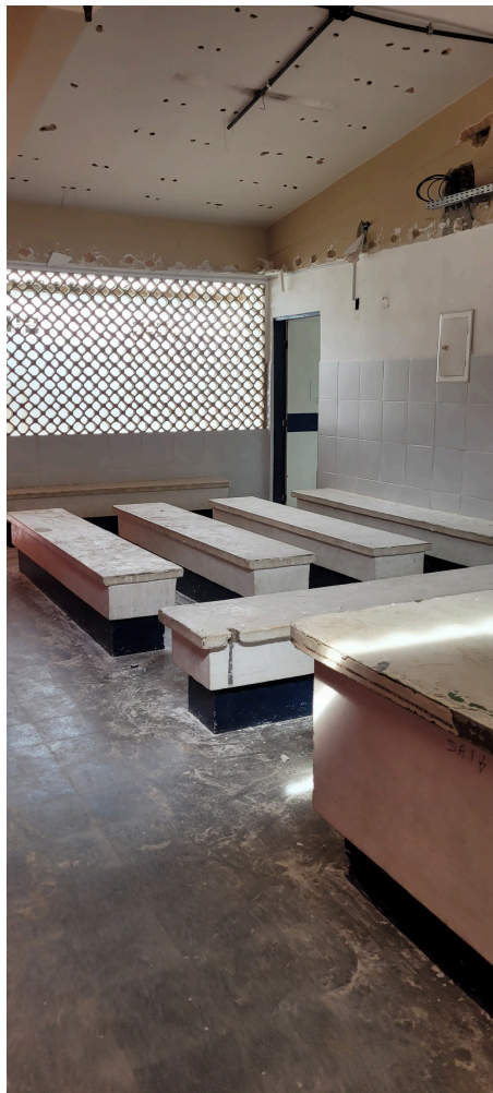
detalhe da reforma do teto na sala de espera
