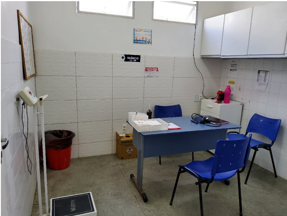
Sala de triagem (foto 1) observar ausência de pia
