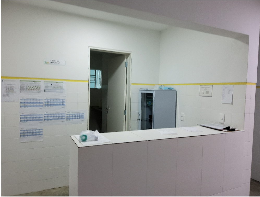
Posto de enfermagem das enfermarias (foto 1)
