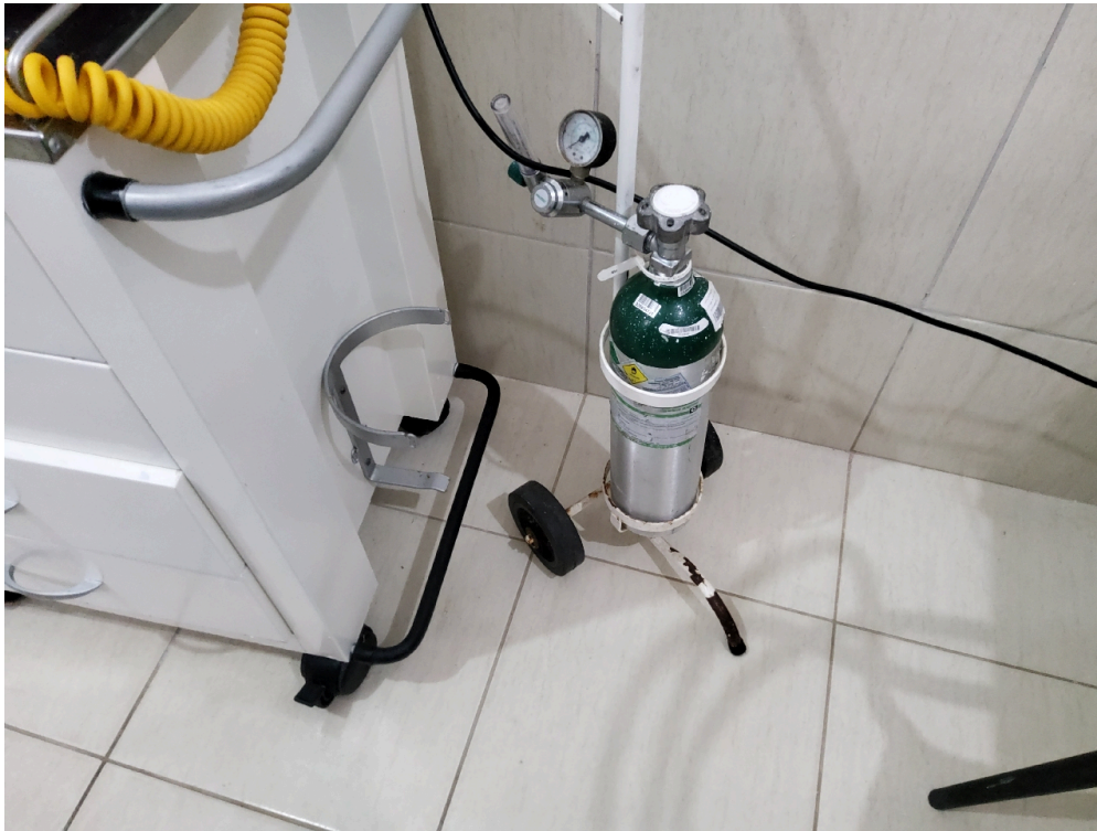
Item não conforme: Fonte de oxigênio com máscara aplicadora e umidificador
