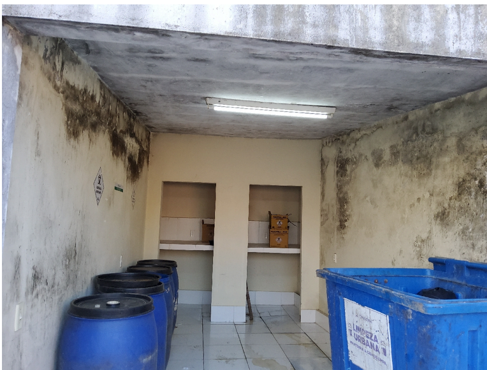
Local de armazenamento de lixo infectante sem grade (observar infiltração)
