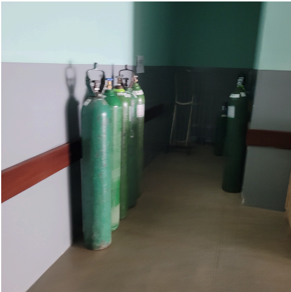
cilindros de oxigênio sem fixação ficam depositados próximo à sala de parto
