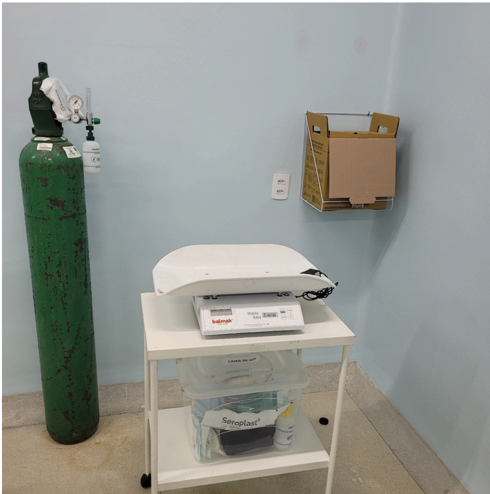
balança pediátrica e cilindro de oxigênio sem fixação dentro da sala de cirurgia
