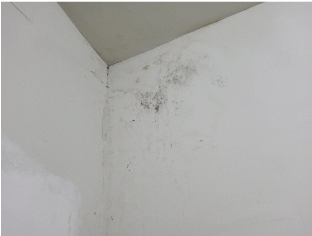
Presença de infiltrações
