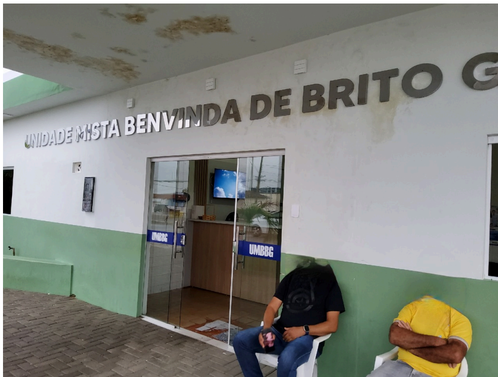
Unidade Mista Benvinda de Brito Galvão (observar infiltração)
